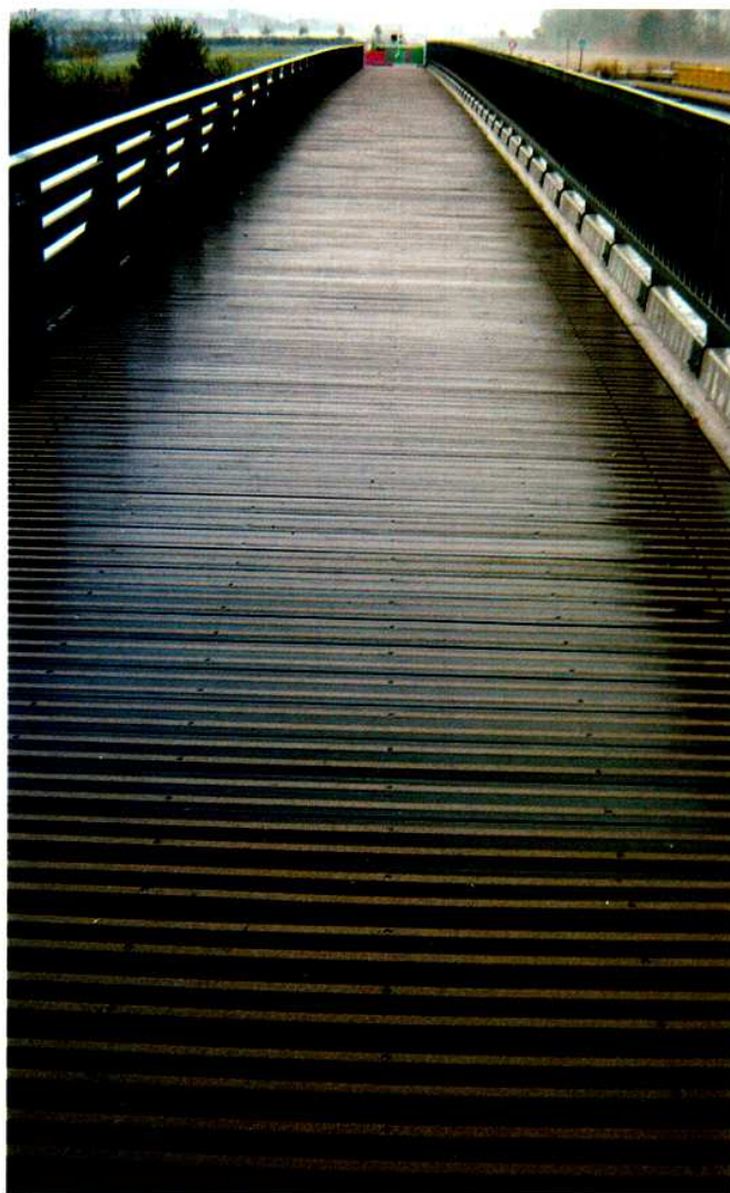
▲ ▲ LES BANDES DE RÉSINE CHARGÉE coulées dans des lames usinées (rainures d'environ 20 mm de large sur 3 à 4 mm de profondeur), sont réalisées en atelier et restent réservées aux ouvrages neufs. C'est le procédé le moins coûteux.
