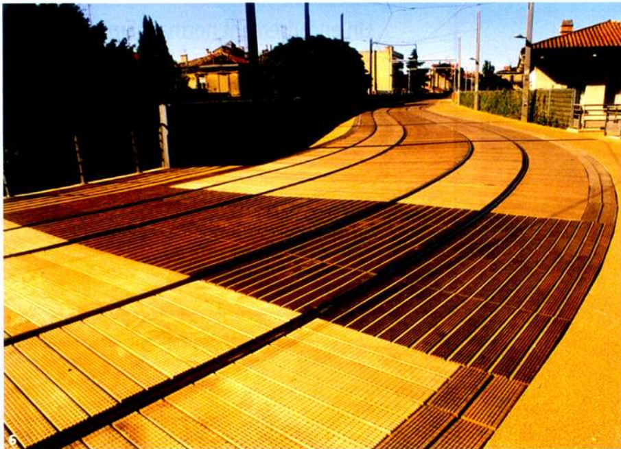
6. PLATelage D'UN SECTEUR DE LA LIGNE DE TRAMWAY DE MONTPELLIER , réalisé en ipé. Il est constitué de panneaux pré-assemblés en usine, les lames étant vissées par dessous, sur deux traverses. Chaque panneau, posé à l'avancement sur les rails, vient recouvrir les fixations du précédent, interdisant l'accès au démontage (seul un sur sept possède un système de verrouillage au sol accessible avec une clé spéciale pour démontage). Le système antiglissement est un profil particulier avec double rainurage croisé, renforcé sur le passage piéton par des baguettes de résine intercalées entre les lames.
