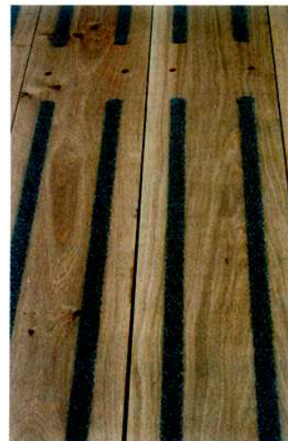
▲ ▲ LES BANDES DE RÉSINE CHARGÉE coulées dans des lames usinées (rainures d'environ 20 mm de large sur 3 à 4 mm de profondeur), sont réalisées en atelier et restent réservées aux ouvrages neufs. C'est le procédé le moins coûteux.
