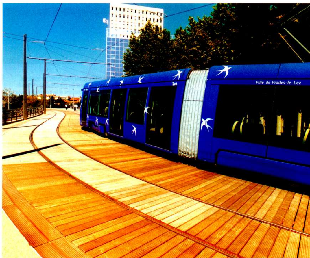
REVÊTEMENT DE SOL EN IPÉ posé sur un secteur de la ligne de tramway de Montpellier. L'ipé a été choisi pour ses qualités de durabilité, de stabilité sous l'effet des chocs thermiques, et de résistance mécanique au poinçonnement. (Doc. Girad-Forêt.)
