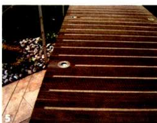
3, 4 & 5 LES PROFILÉS ALU EN FORME D'ÉQUERRE, posés en bout de lame, se fixent par vissage inox sur le dessus à raison de 4 point par mètre. La pose peut être réalisée sans défonçage des lames (surépaisseur de 5 à 6 mm) ou avec défonçage sur 3 mm (surépaisseur de 2 à 3 mm). (Doc. Ouest Réparations Résines.)
